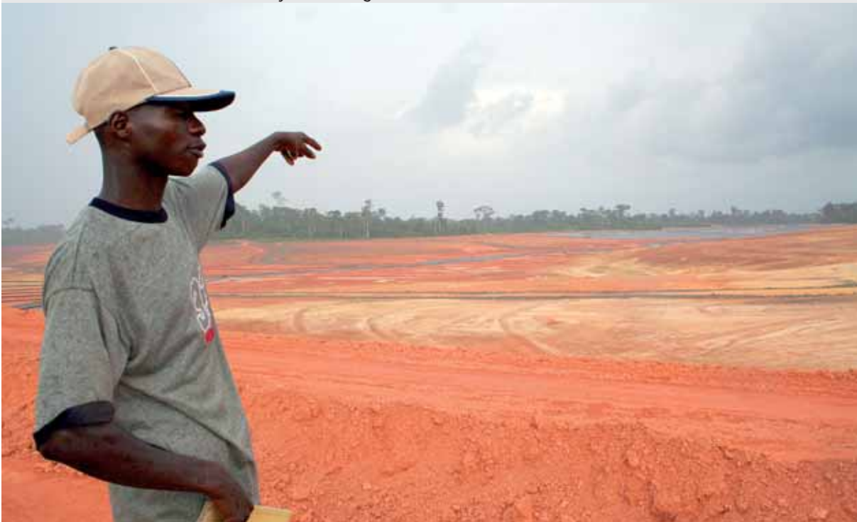
Bau eines Rückhaltebeckens für cyanidhaltige Abwässer in Ghana (Foto: Ute Hausmann/FIAN)
