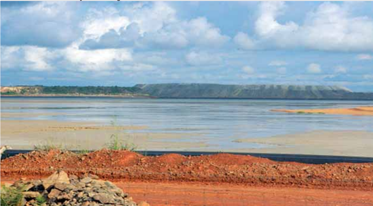
Rückhaltebecken für cyanidhaltige Abwässer in Ghana (Foto: Sebastian Rötters/FIAN)
