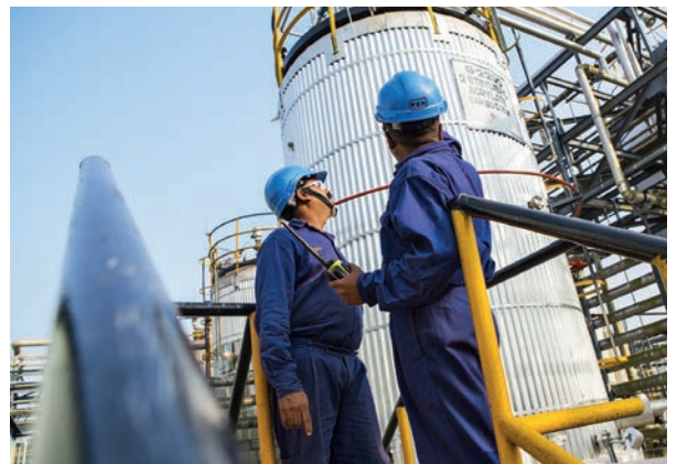
Von BASF errichtete Industrieanlage in Mangalore/Indien als Beispiel für Ausländische Direktinvestition, Foto: BASF/Flickr.com
